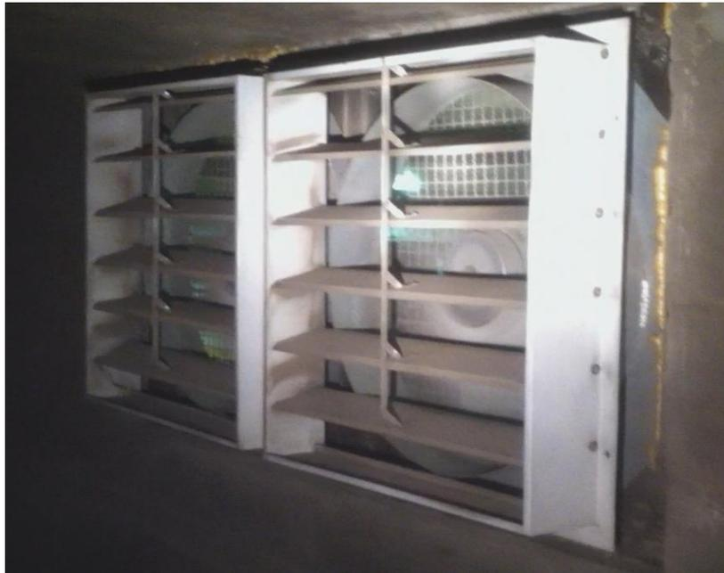
Ilustración 2: Celosías gravitacionales del sistema de ventilación del grupo B de SER Neptuno. Se aprecia en esta fotografía que las celosías operan correctamente abriéndose completamente al paso del aire.
