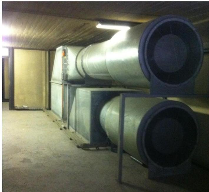
Ilustración 4: Ventiladores Tubulares con silenciadores.
