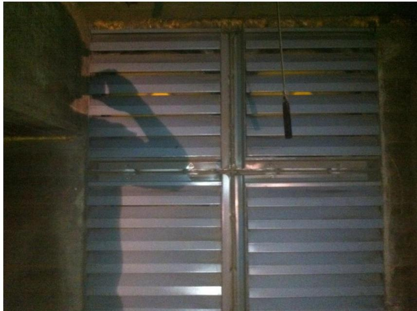
Ilustración 1: Celosías gravitacionales de ventiladores de SER Neptuno con ventiladores funcionando, se aprecia que no se alcanzan a levantar completamente.
