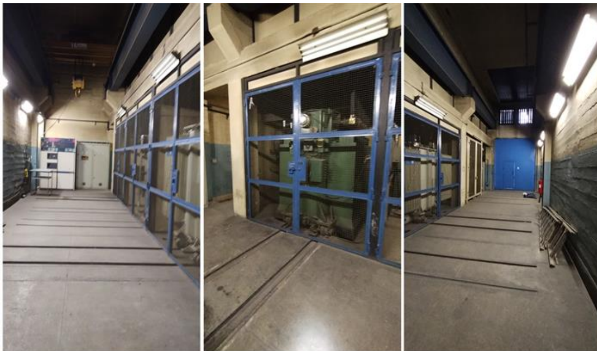
Ilustración 2: Típica instalación de la SER. Transformador 4,5 MVA
