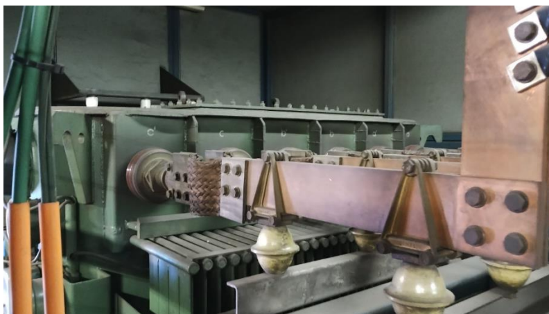
Ilustración 5: Terminales de baja tensión. Situación típica.
