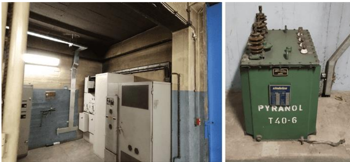
Ilustración 11: Típica instalación de la SER, interior gabinete izq. Transformador auxiliar 40 kVA der referencial.
