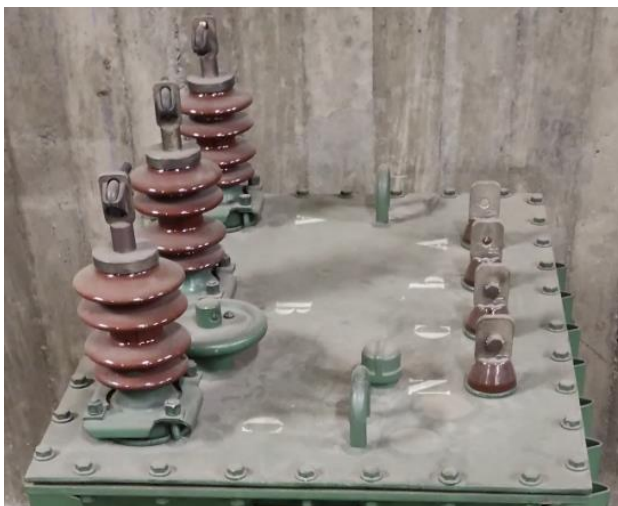
Ilustración 12: Transformador existente 40 kVA. Referencial
