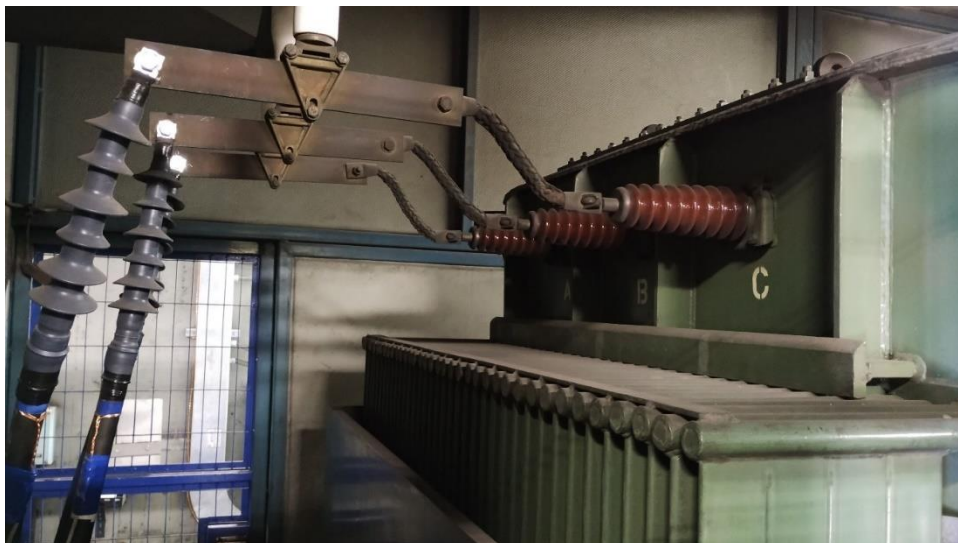
Ilustración 4: Terminales de alta tensión situación típica
