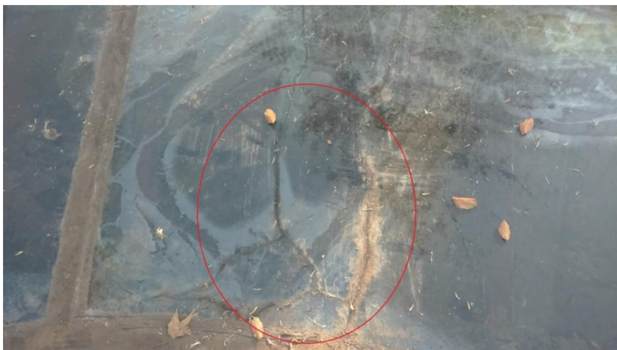
IMG. N°19: MUESTRA CRISTAL DAÑADO ESTACION PLAZA EGAÑA
