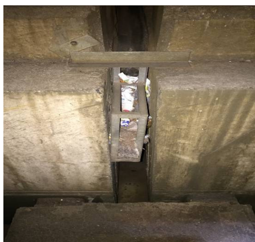
Imagen n°3: Fotografías Rejillas Auxiliares Sumidero Columna Interestación L4
