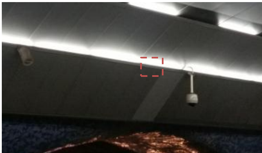
Figura N° 198: En Techo con Mástil Vertical
