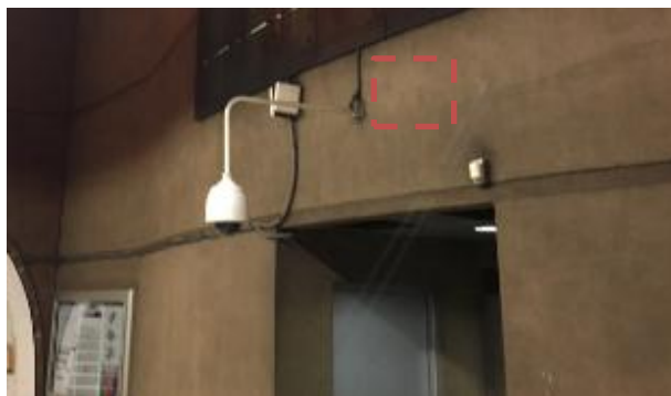
Figura N° 237: En Pared con Mastil Horizontal Nuevo
