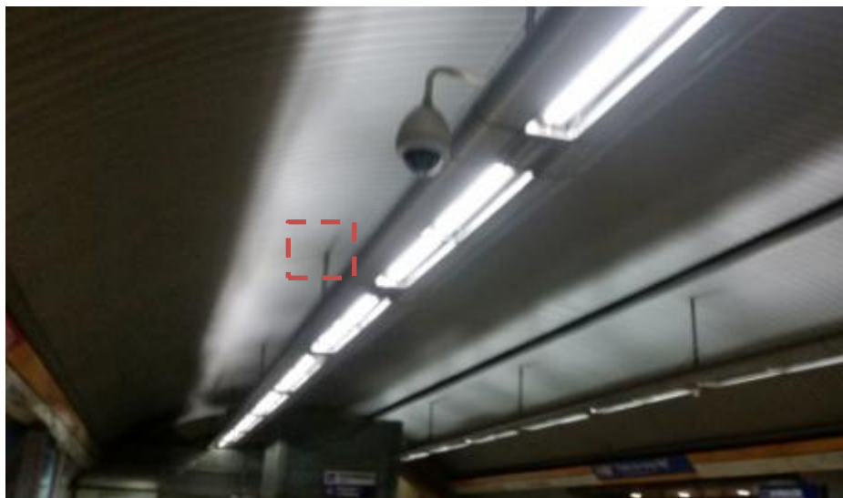
Figura N° 204: En Techo Luminarias con Mástil Vertical
