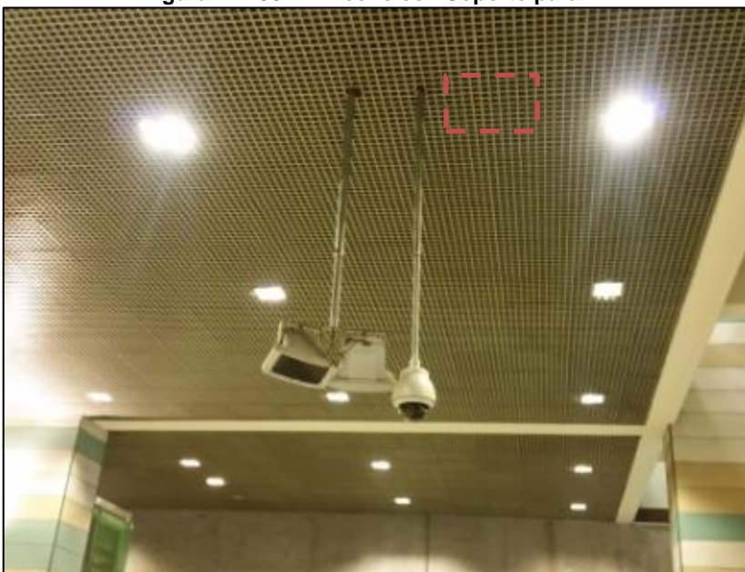
Figura N° 159: En Techo con mástil Vertical
